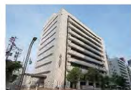
▲宮城県仙台合同庁舎
